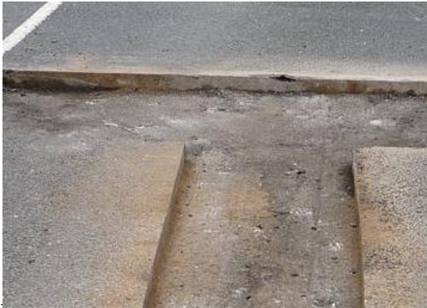
Fig II.B.1 Remoción de carpeta superficie asfáltica.
