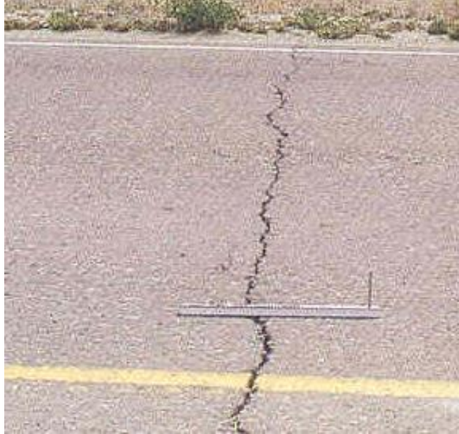
Figura I.A.6.1 Grietas Transversales
