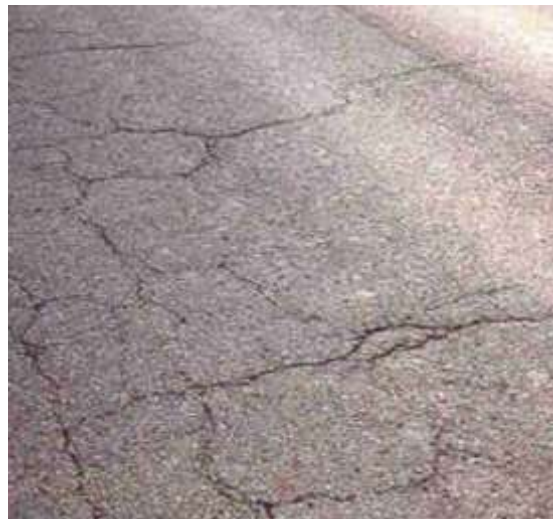
Grieta de Bloque
