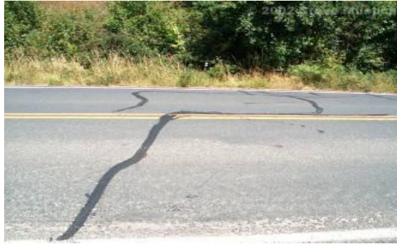
Figura II.B.1 Sellado de Grietas Aisladas
