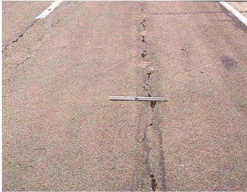
Figura I.A.4.1 Grieta longitudinal
